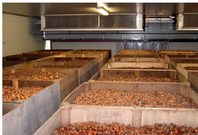
Door goed te letten op aspecten als ethyleengehalte en RV is tijdens de bewaring op energie te besparen
