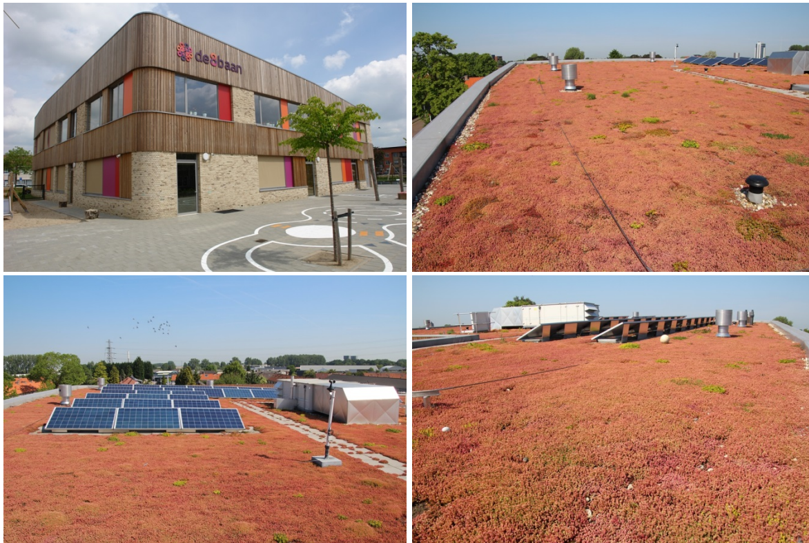
Figuur 8 Overzicht van het aanwezige groendak, situatie van 5 juni 2015, op R.K. basisschool De Achtbaan. Foto: Fabrice Ottburg©.
