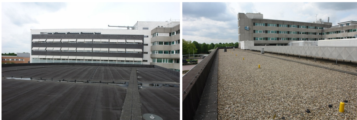
Figuur 12 Voorbeelden van traditionele platte daken, links uitgevoerd met dakleer en rechts een combinatie van dakleer met grind. Foto's: Fabrice Ottburg©.
