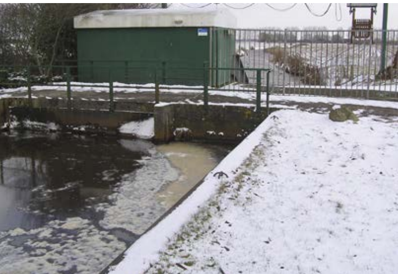
Rijperkerkgemaal aan de Rijperkerkstervaart, februari 2010.
