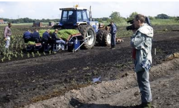
Aanleg helofytenfilter en aanplanten van riet nabij het Nanneviid, juni 1994.
