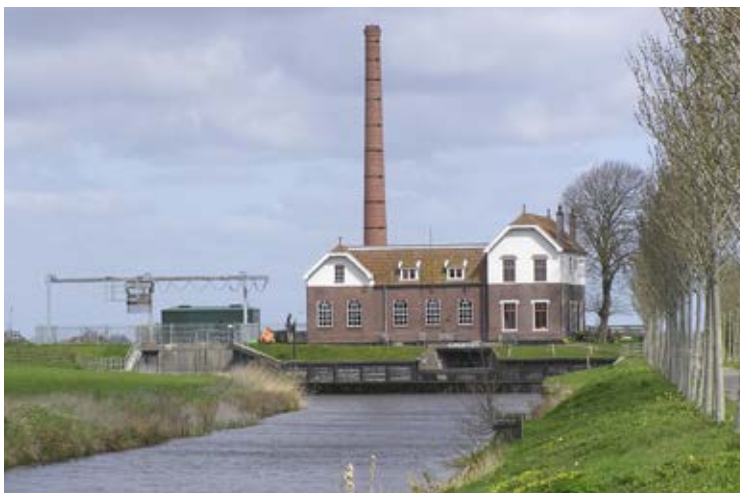
Oud en nieuw gemaal van de Veenpolder van Echten. Vanaf de eerste bemaling in de 2 e helft van de 19 e eeuw is het polderpeil verlaagd van -1,0 m NAP, via -2,8 m NAP, naar -3,4 m NAP (foto april 2010).
