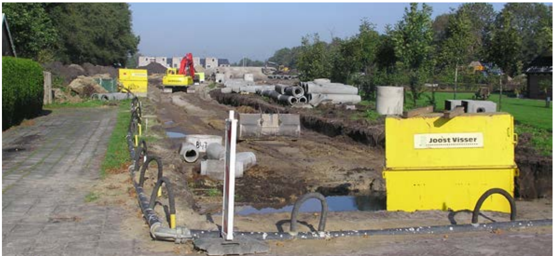
Aanleg van riolering in Burgum, oktober 2006.
