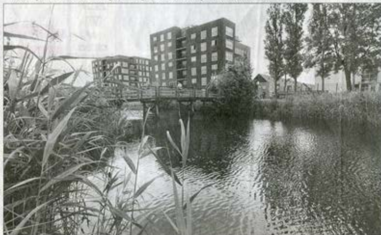
Het gebied rond de Potmarge in Leeuwarden is een voorbeeld van een geslaagde herinrichting, met oog voor de ecologische waterkwaliteit. Foto: Frans Andrijs
