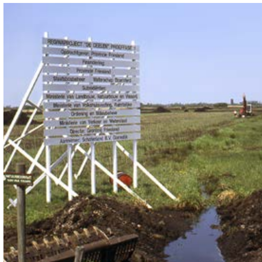
Aanleg helofytenfilter in De Deelen, mei 1992.
