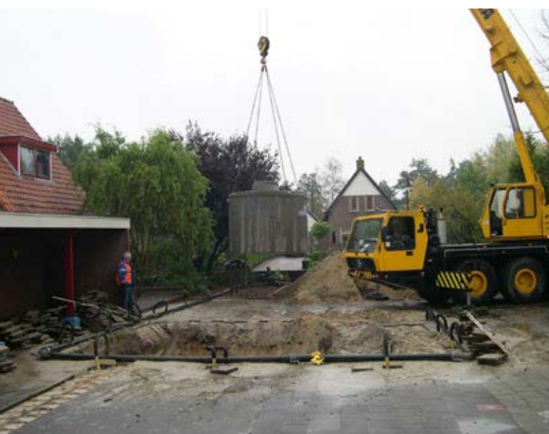
Plaatsing regenwaterbenuttingstank bij school De Tike, oktober 2006 (foto gemeente Smallingerland).
