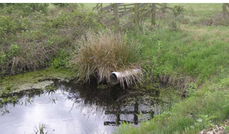
Versnippering op verschillende schaalniveaus: te hoog liggende duiker en geïsoleerd liggend natuurgebied (luchtfoto van Benny Klazenga, april 1990).
