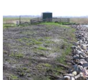
Kadeverbeteringswerken bij de Wydlannen, Alde Feanen bemoeit visintrek de polder in, april 2008.
