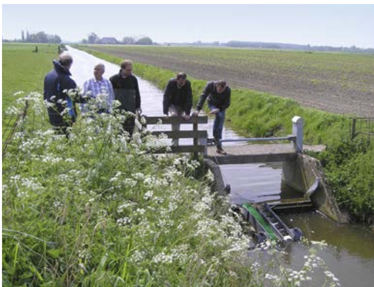
Kleinste vistrap met aalgot bij de Blikfaart, aangelegd in mei 2014 (foto M. Thannhauser).
