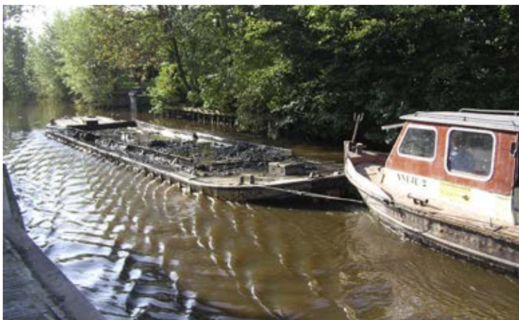
Baggerwerk in de Murk te Aldtsjerk, oktober 2006.
