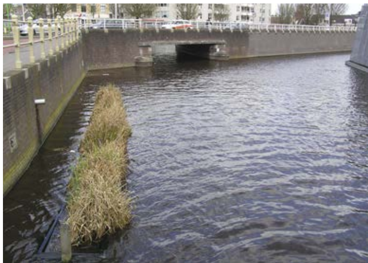
Floatland, drijvend moerassysteem ter vergroting van de natuurbeleving, biodiversiteit en voor nutriëntenverwijdering in Leeuwarder stadsgracht, broedplaats voor meerkoeten en verzamelplaats voor drijvend vuil.
