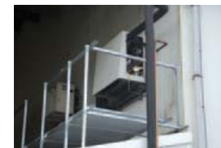
Warmtewisselaar De warmtewisselaar draagt de koude van het propaan over aan de CO 2 .
