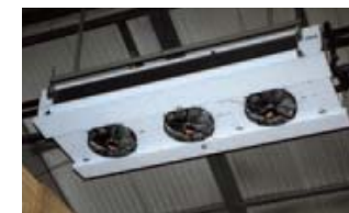
Propaan en CO 2 Het secundaire circuit van de CO 2 -propaaninstallatie is gevuld met CO 2 .
