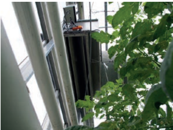
Figuur 7.3 De buitenlucht inblaas installatie van bedrijf VB. Links is de behuizing van de ventilator, inblaasopening naar de slang en de mengklep te zien. Rechts de doorzichtige slang zoals deze boven het gewas hangt. De slangen eindigen boven het middenpad (rechtsonder).
