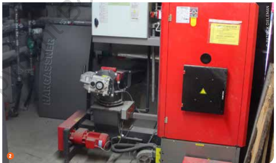
1 De ruggen worden aangelegd met een speciale machine. Er komt een antiworteldoek bovenop en de geul bovenaan wordt gevuld met turf. Daarin planten gaat volgens Lieven heel vlot. 2 De houtsnippers komen in de kachel via een vijzel. Lieven ondervond dat hardere houtsoorten minder as opleveren dan zachte.
