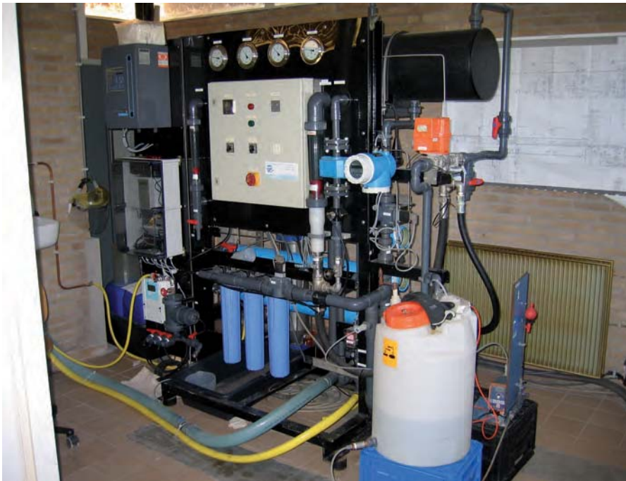
Proefinstallatie omgekeerde osmose te Dinxperlo
