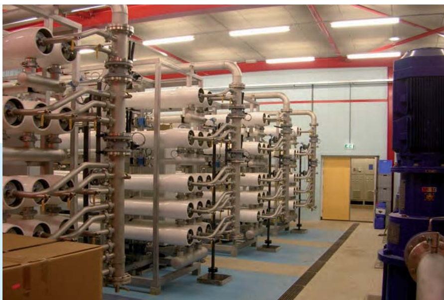
Membraaninstallatie op productiebedrijf Dinxperlo (foto: Logisticon).
