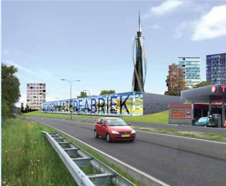
Artist impression van de toekomstige MBR Alkmaar (de Schoonwaterfabriek), waar de MBR tevens dienst doet als geluidswal (bron: GroupA).
