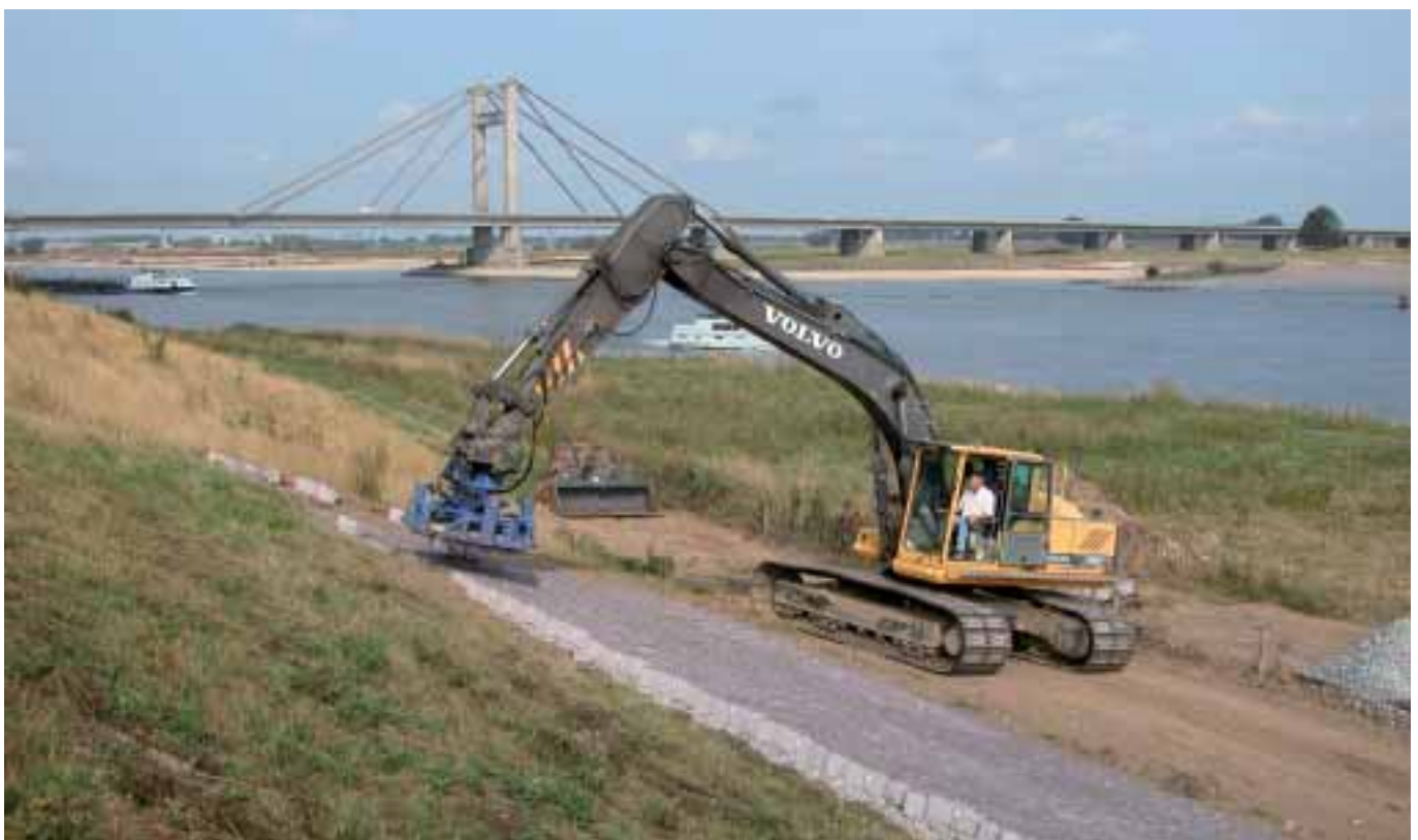
Dijkverbetering in het beheergebied van Waterschap Rivierenland bij Beneden-Leeuwen
