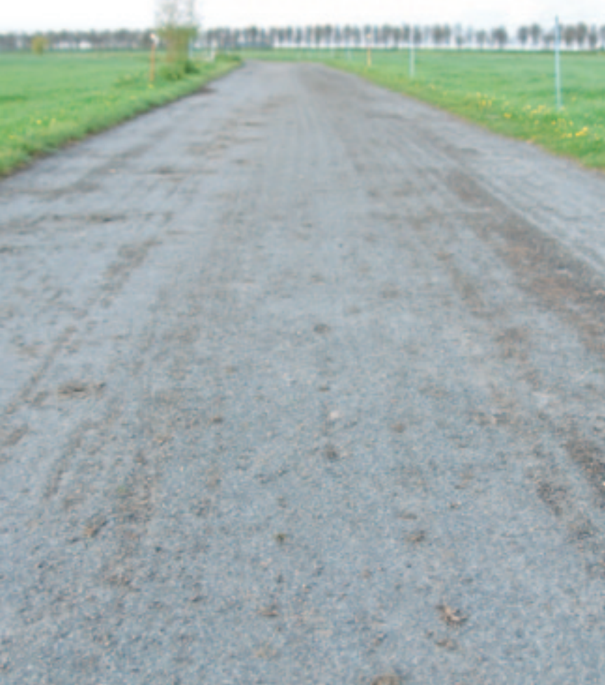
Een kavelpad van natuurlijk beton heeft een natuurlijke uitstraling. De berijdbaarheid ervan is afhankelijk van de grondsoort. Dit pad is nu vijf jaar oud.
