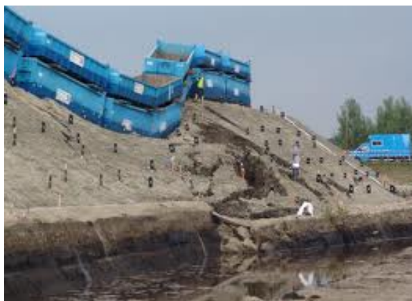
Figuur 5 Foto van het bezwijken van een met vele sensoren en ICT gemonitorde dijk (bron: Stichting IJkdijk).
