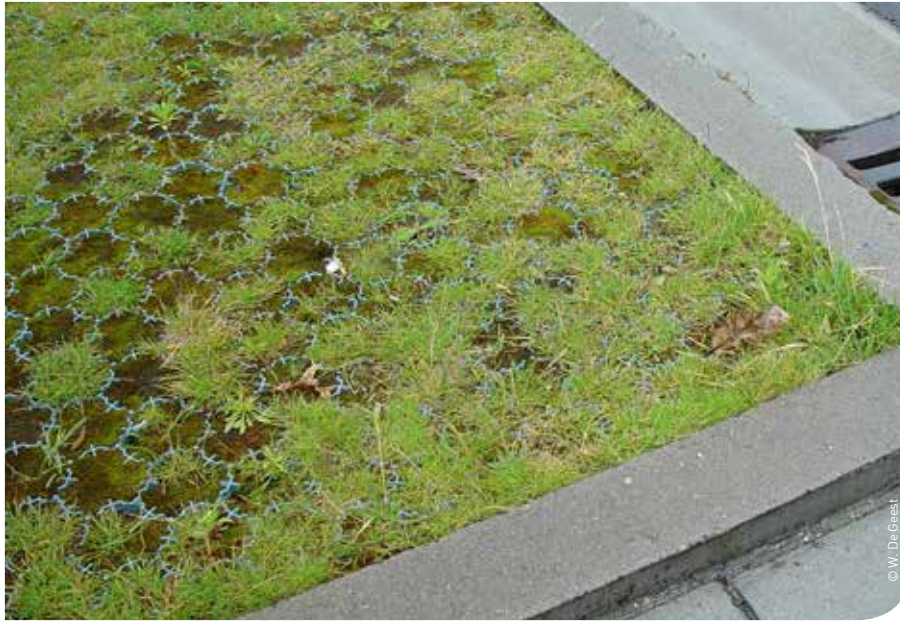
Nieuwigheden op de ecochequelijst zijn de aankoop en plaatsing van grastegels (met honingraatstructuur) en waterdoorlatende tegels.
