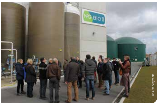
▲ De NPG Biomassacentrale in Kallo
