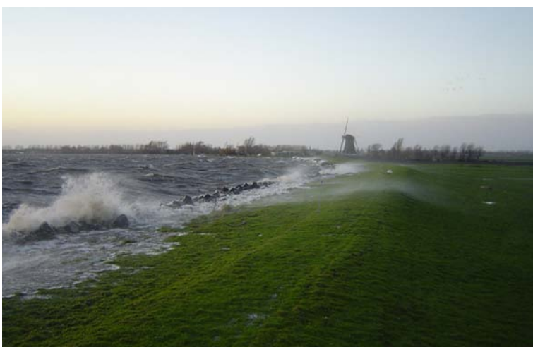
Afbeelding 2. De kades zijn verhoogd en verbreed om ze te stabiliseren en beter bestand te maken tegen golfploop, zoals hier aan de oostzijde van het Braassemermeer
