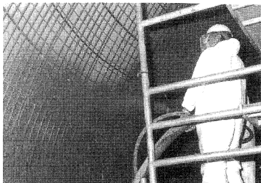
Bij de silo op ROC Cranendonck werd het beton aan de binnenzijde van de mal tegen de wapening gespoten volgens de natte methode.
