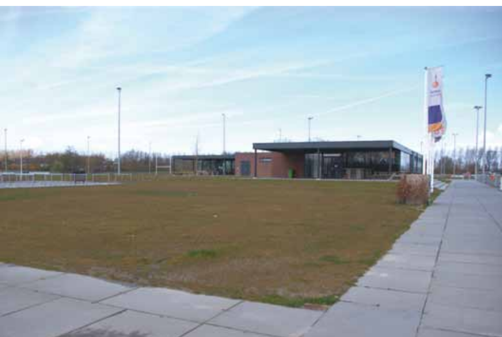
Onder het grasveld naast het clubgebouw zijn de filter- en pompinstallatie ondergebracht.
