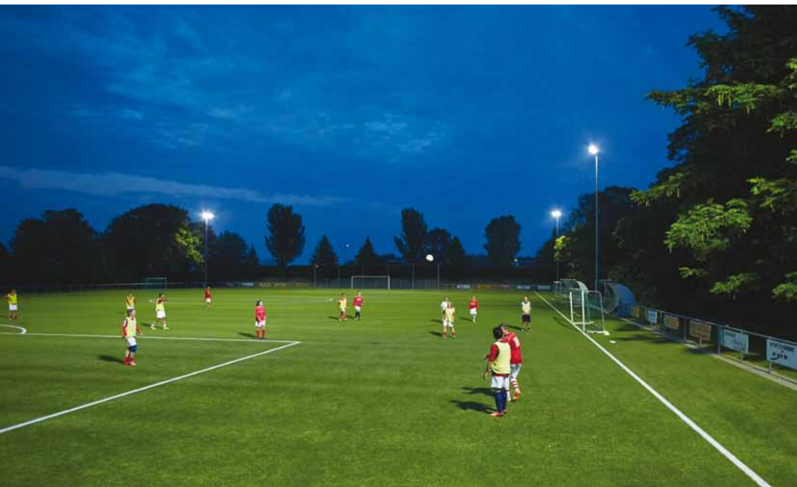
Om alle vochtmetingssensoren aan elkaar te kunnen verbinden worden op voldoende diepte kabels in het veld gelegd. Daardoor levert het vervangen van een gras- of hybridemat geen problemen op.
