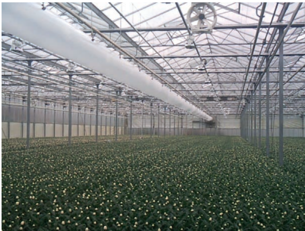
Figuur 3 Proefvak met luchtbehandelingsinstallatie.
