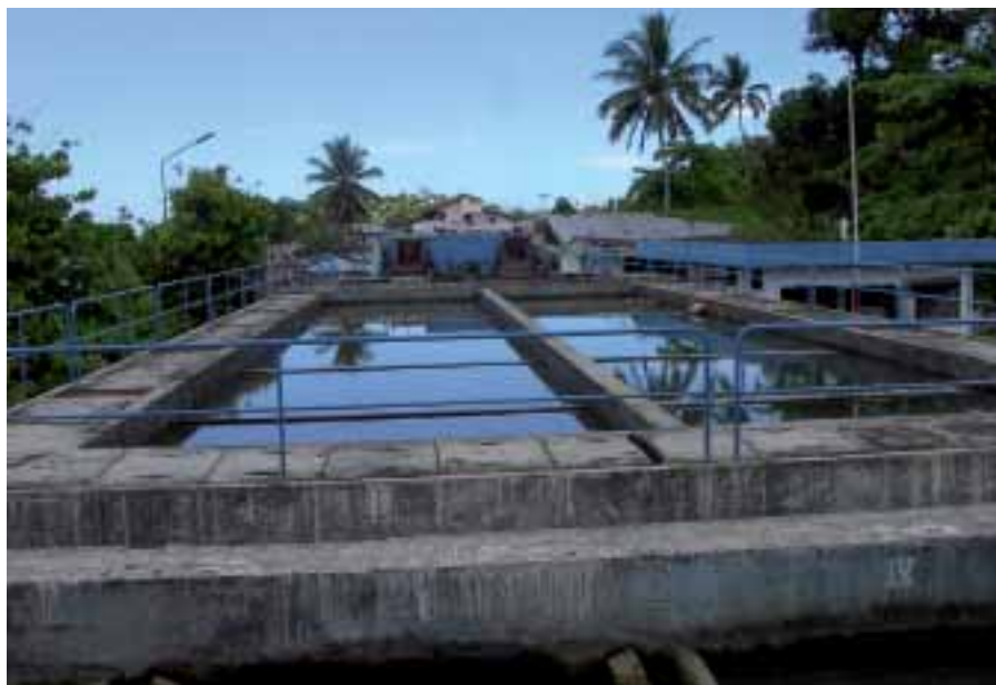
De huidige staat van de zuiveringsinstallatie van Manado.
