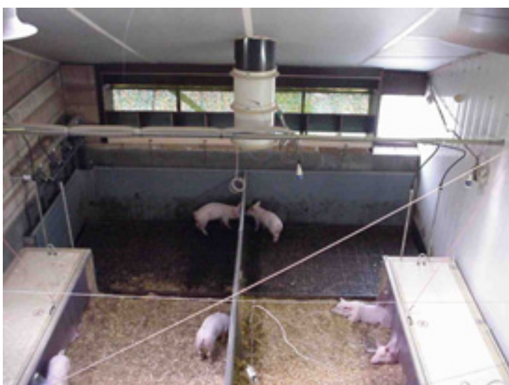
Overzicht van de afdeling met de twee beddenstalhokken. Linksboven en rechtsboven de luchtafvoerkokers, de koker in het midden was afgesloten en deed niet mee in de proef
