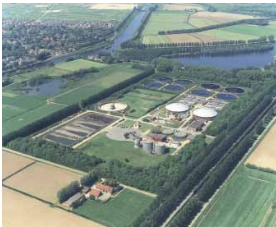
De rioolwaterzuiveringsinstallatie in 's-Hertogenbosch.
