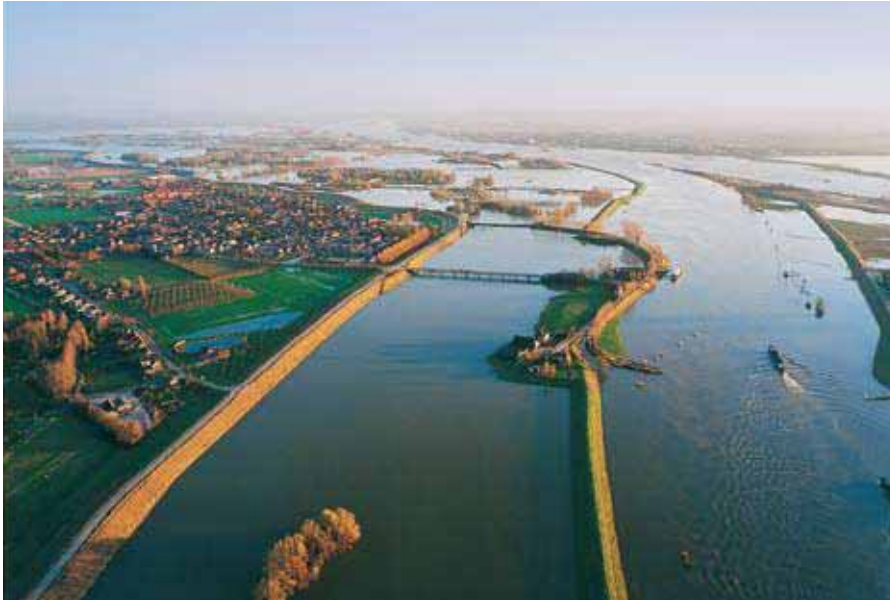
'Groene rivier' bij Pannerden, ter vergroting van de afvoercapaciteit van het Pannerdensch kanaal (foto: Rijkswaterstaat Meetkundige Dienst).
