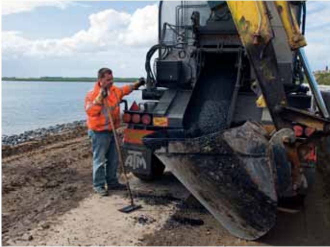
Het ingieten van de breuksteen met gietasfalt.
