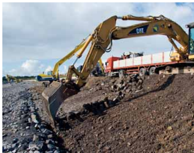
Graafmachine haalt delen van de oude basaltbekleding weg.
