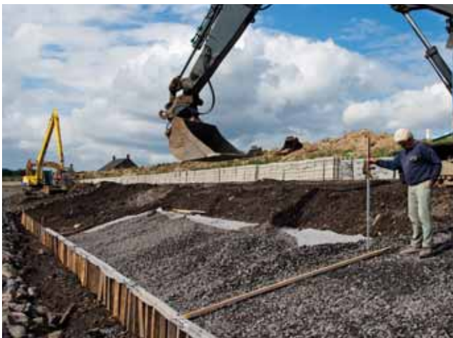
Boven de gemiddelde hoogwaterlijn wordt een filterlaag aangelegd met steenslag op een waterdoorlatend geotextiel.
