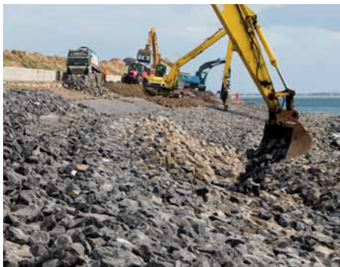
Het aanbrengen van breuksteen.
