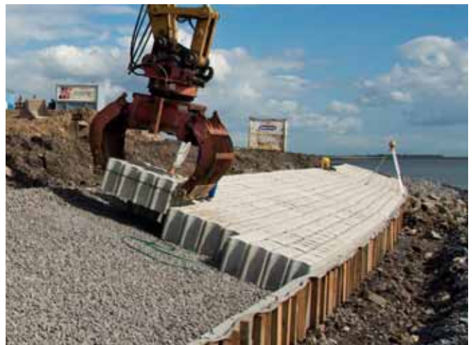
Een kraan legt met gemak 500 vierkante meter betonblokken per dag.
