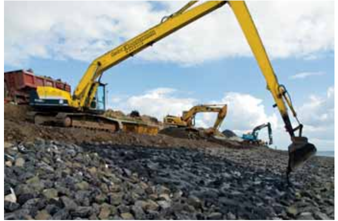
Onder de hoogwaterlijn is een dikke laag grove breuksteen gestort die gefixeerd wordt met gietasfalt met daarop een laagje fijner breuksteen waarop wieren zich kunnen vastzetten.
