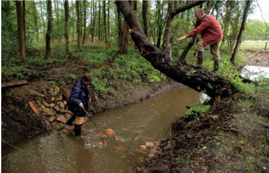
Stenen vispassage in het Anreperdiep ter hoogte van Assen. Regelmatig onderhoud is noodzakelijk om de werking van de vispassage te garanderen. De hydroloog geeft aanwijzingen en tips (foto: Herman Wanningen).
