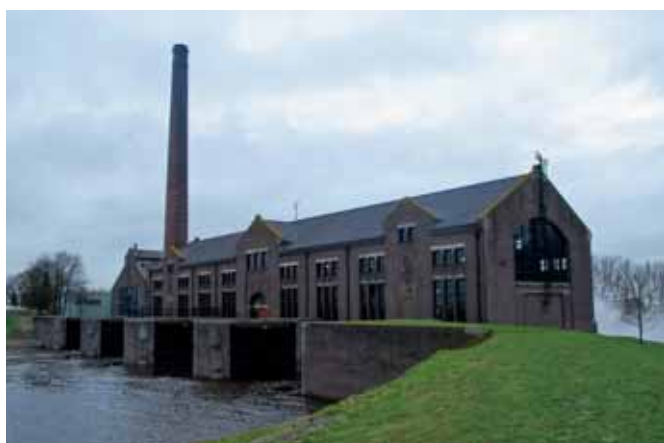
Draaien de stoommachines op volle kracht, dan pompt het gemaal vier miljoen liter water per minuut uit de boezem het IJsselmeer in.
