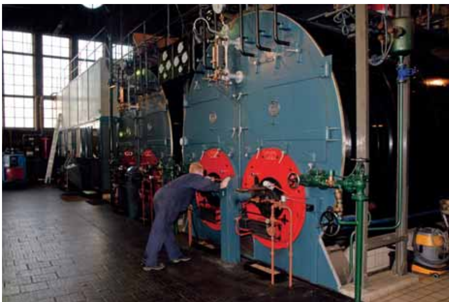
Regelmatig moeten de filters waarmee stoom gereinigd wordt, vervangen worden.
