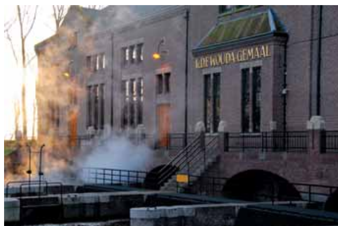
Tijdens het opstarten stoot het Woudagemaal stoom uit.
