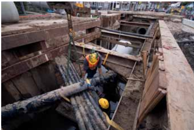
Met het verplaatsen van de kabels wordt de rioolbuis langzaam op zijn plaats geschoven.
