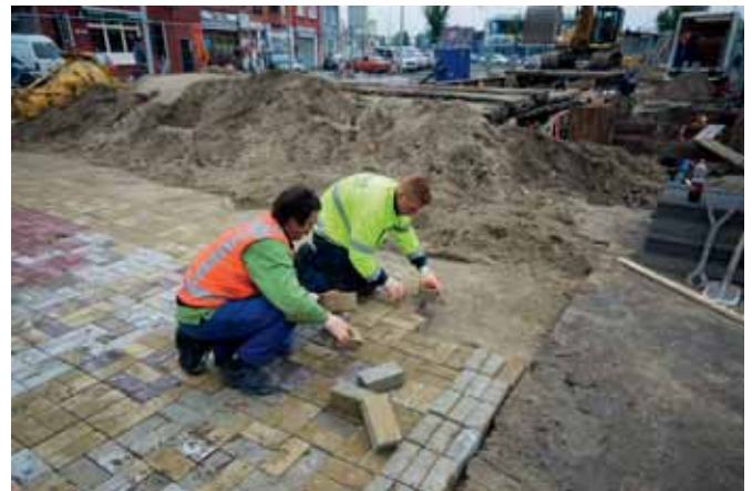
Zo snel mogelijk na het plaatsen van de rioolbuizen moet de straat gedicht worden en herbestraat.
