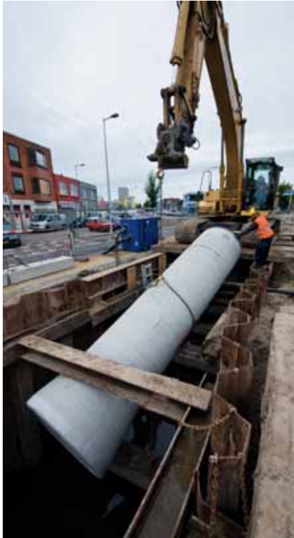
Met het verplaatsen van de kabels wordt de rioolbuis langzaam op zijn plaats geschoven.
