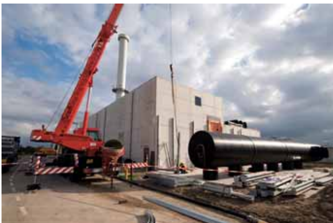
Vorbereidingen voor het plaatsen van koolfilters naast het filtergebouw.
