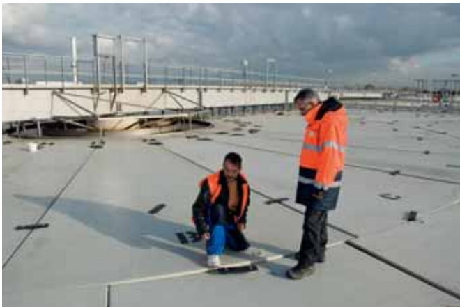
Ed Visser brengt nieuwe koppelingen aan aan één van de drijvende deksels van een nabezinktank. Rechts Marcel van den Berg.
