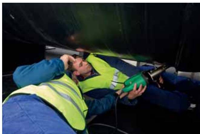
Lassen van de luchtverdeelleiding waardoor lucht naar het koolfilter stroomt.
