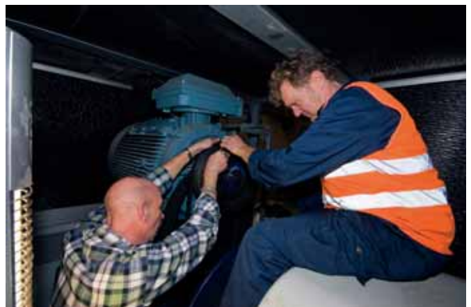
Ed Sodenkamp (l.) en Richard Hakkaart (r.) vervangen de snaren van de centrifuge die het slib indikt.
