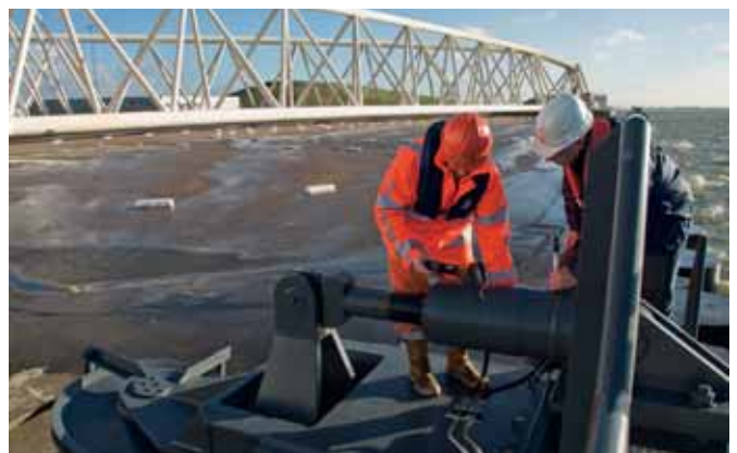
Tom Dullemond en Derek Place verrichten een hydraulische meting van het aantrekmechanisme van de dokdeur.
