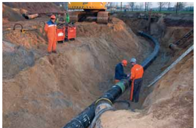
Een gasleiding moet verlegd worden voor de Doorbraak.
