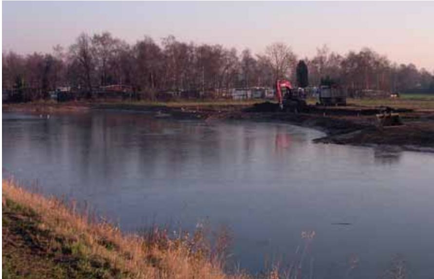
Aanleg van de ecologische verbindingzone Putwielen.
