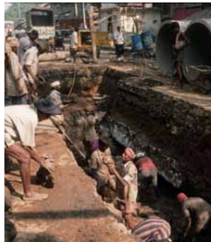
De aanleg van riolering in Bombay (foto's: Johannes Odé).
