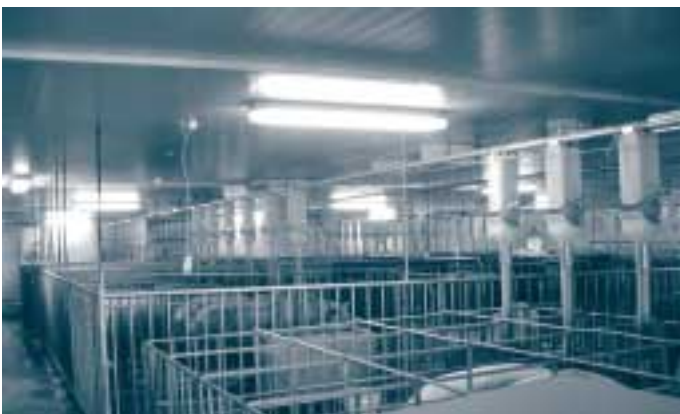
De dek-wachtstal en de kraamstal zijn geïsoleerd en worden mechanisch geventileerd.
