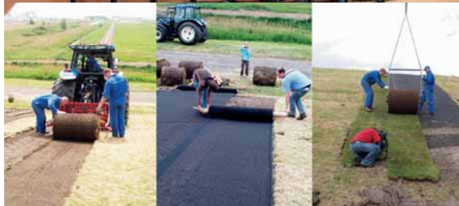
Versterken van de dijk met gaas en gras.
