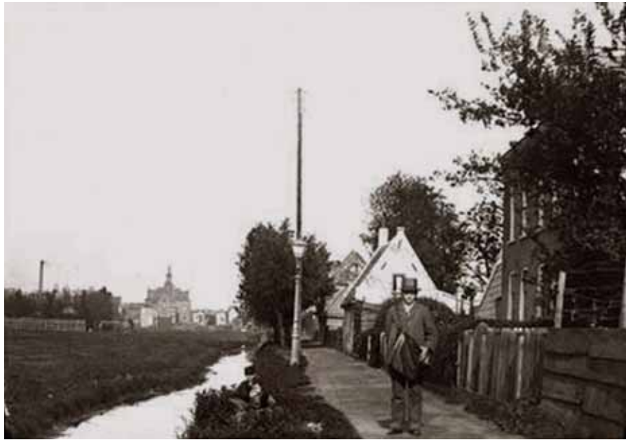
Polderrioleringsgebied Tolstraat toen het nog een polder met sloten was.
