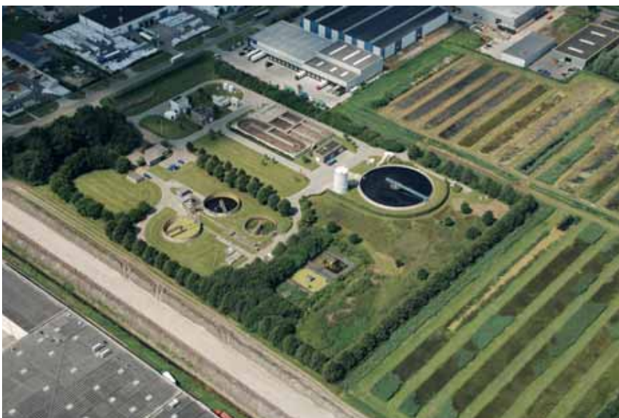
De afvalwaterzuiveringsinstallatie Zeewolde (foto: Bert Broekman).
