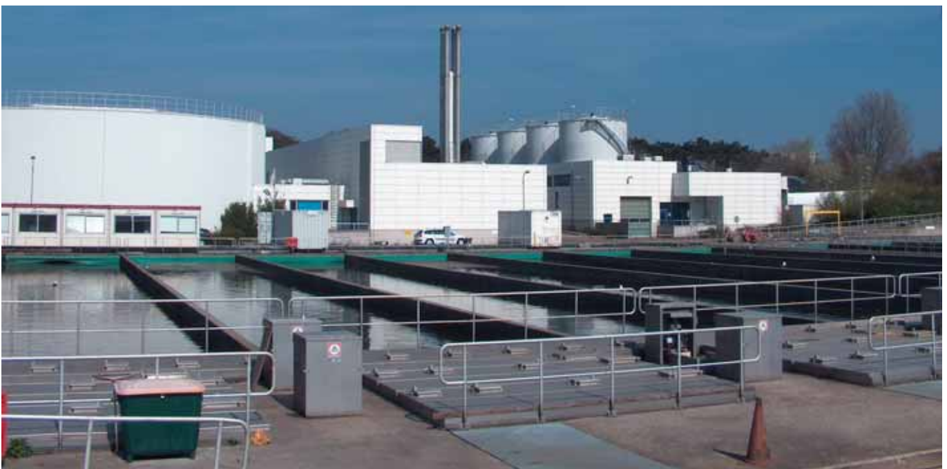
De renovatie van de afvalwaterzuiveringsinstallatie Houtrust zal ruim voor 1 november afgerond kunnen worden.
