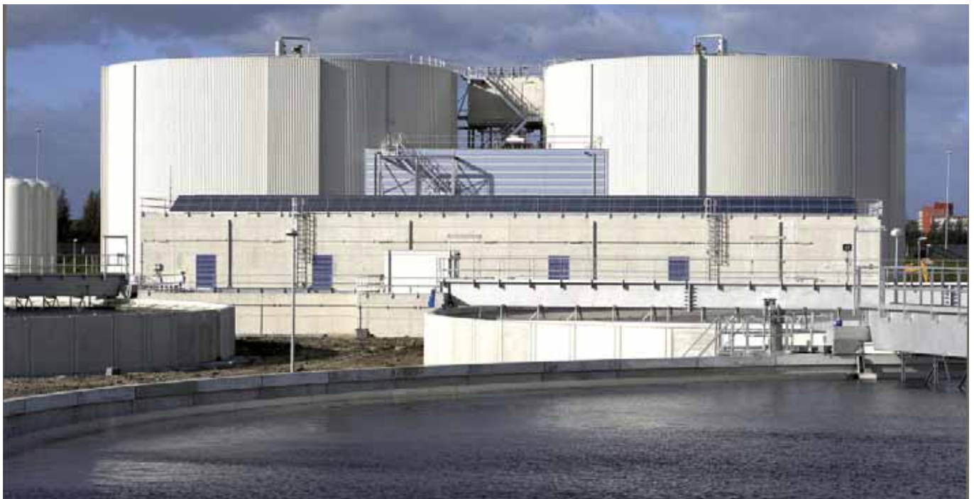
De nieuwe afvalwaterzuiveringsinstallatie Harnaschpolder in Den Haag (foto: Martin Kers).
