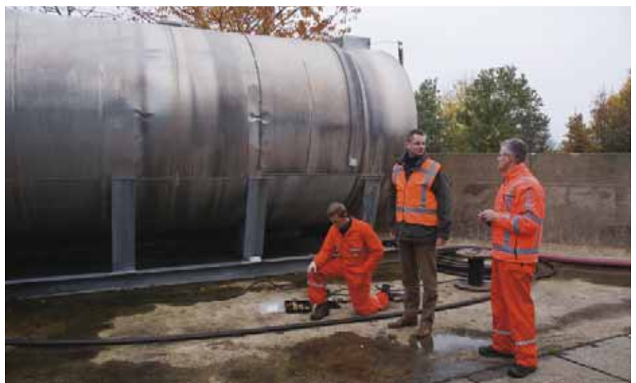
In de opslagtank kan 50 kubieke meter urine worden opgeslagen.
