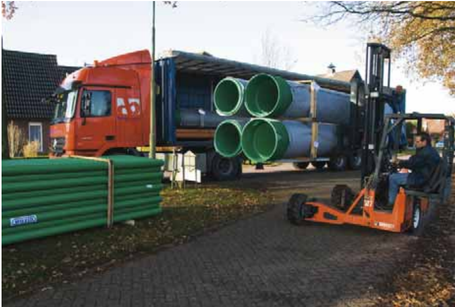
De aanvoer van de buizen.
