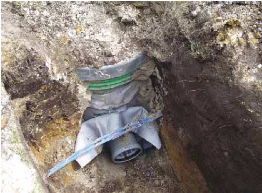
De infiltratiebuizen met een doorsnede van 50 centimeter.
