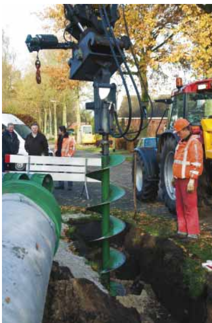
Boring in de Exloërweg in Ees.
