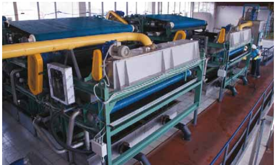
De twee bandzeefndikkers zorgen voor vermindering van stankoverlast.
