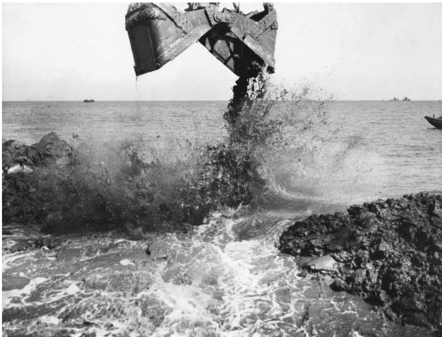
De bouw van de Afsluitdijk.
