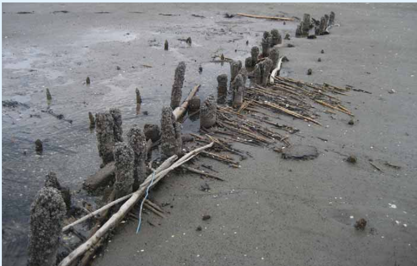
Rijschoutdammen op Groningse kwelderwerken voor...
