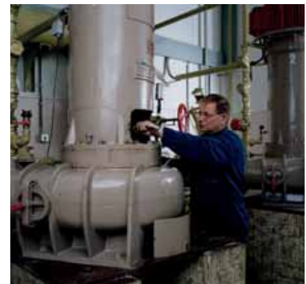
Onderhoud aan rioolgemaal Cuijk.
