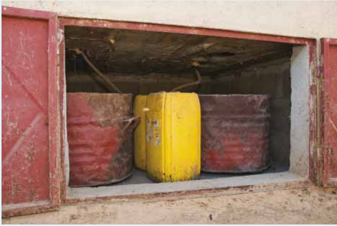
Onder het toilet staan twee halve tonnen: een voor de opvang van ontlasting, de ander voor het waswater. Urine wordt in een aparte jerrycan opgevangen.
