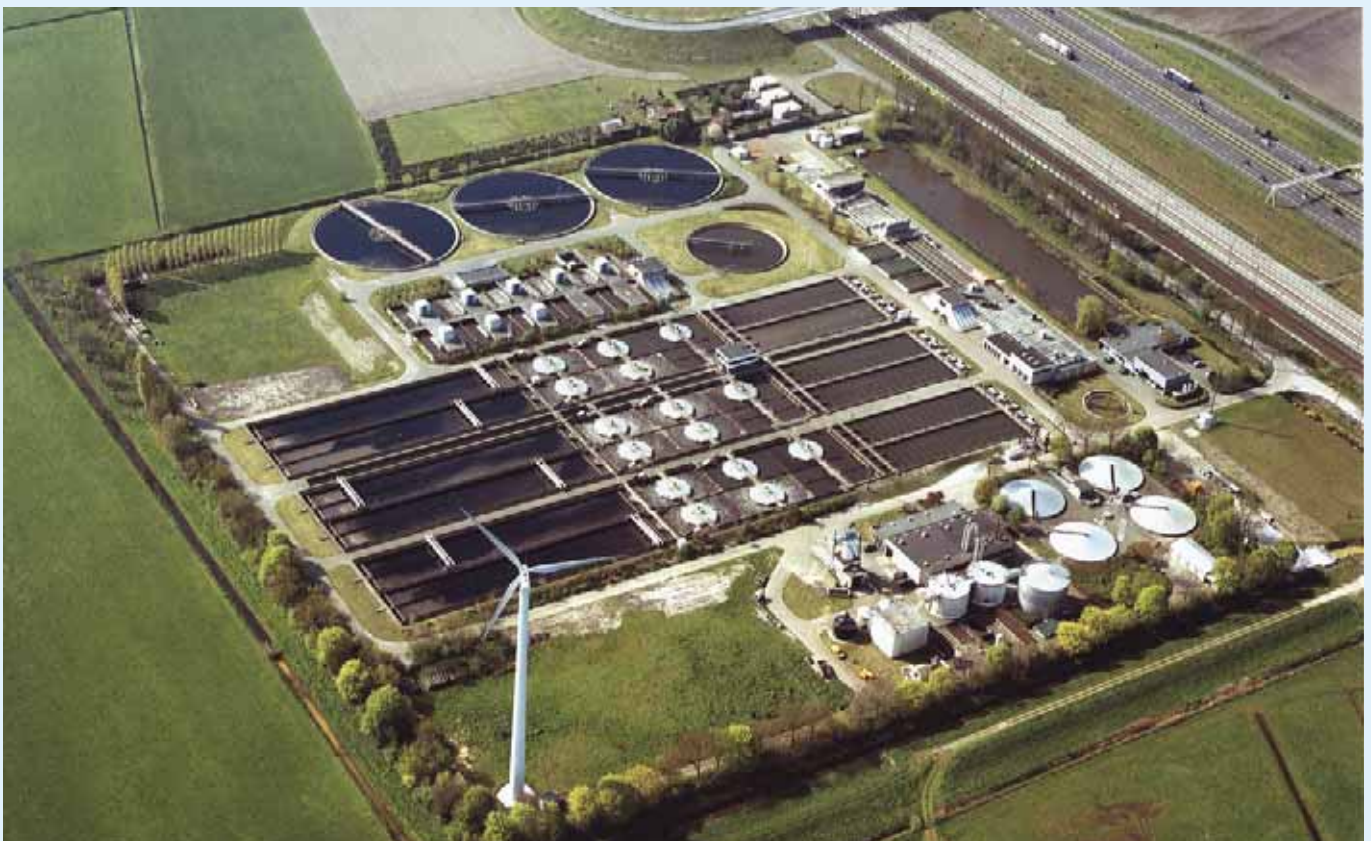
De rioolwaterzuiveringsinstallatie Nieuwveer ten noorden van Breda.
