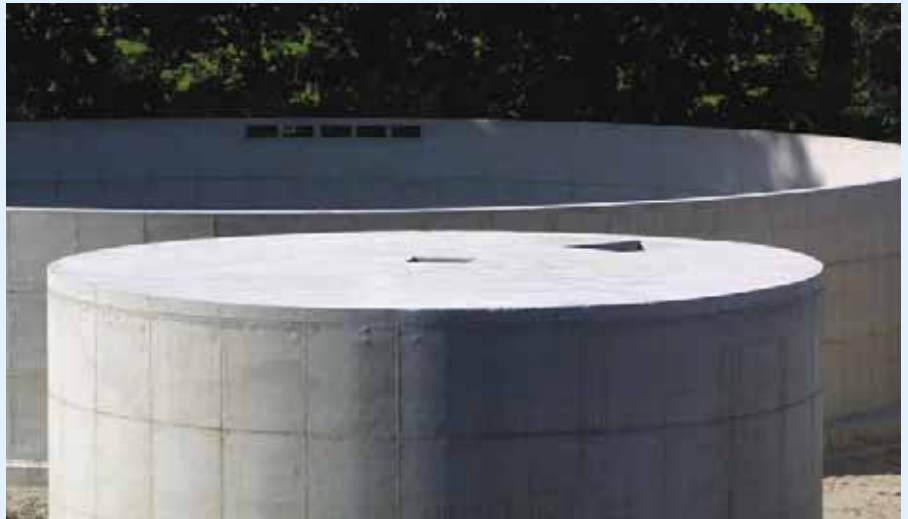
Modulaire betonnen tankbouw.
