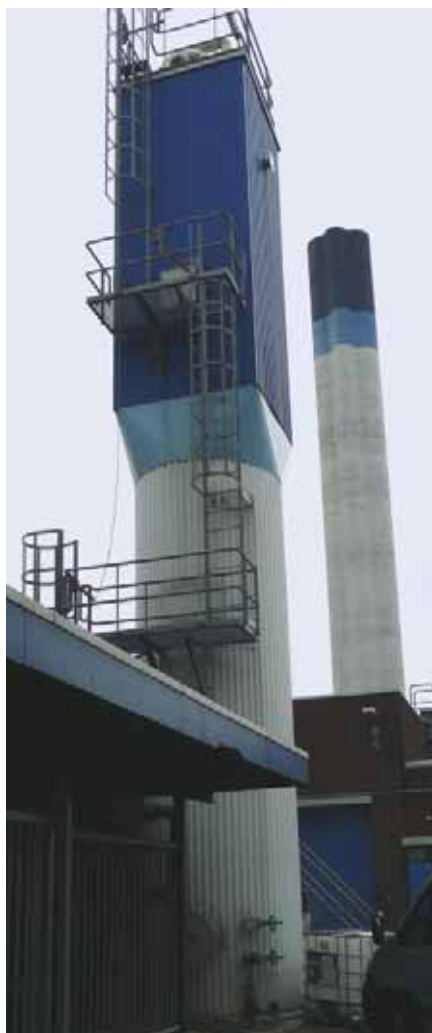
De anammoxreactor te Sluisjesdijk.
