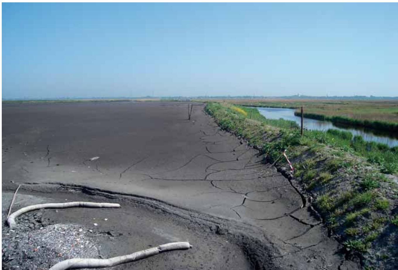
Zicht op één van de baggerdepots in de zomer van 2008.
