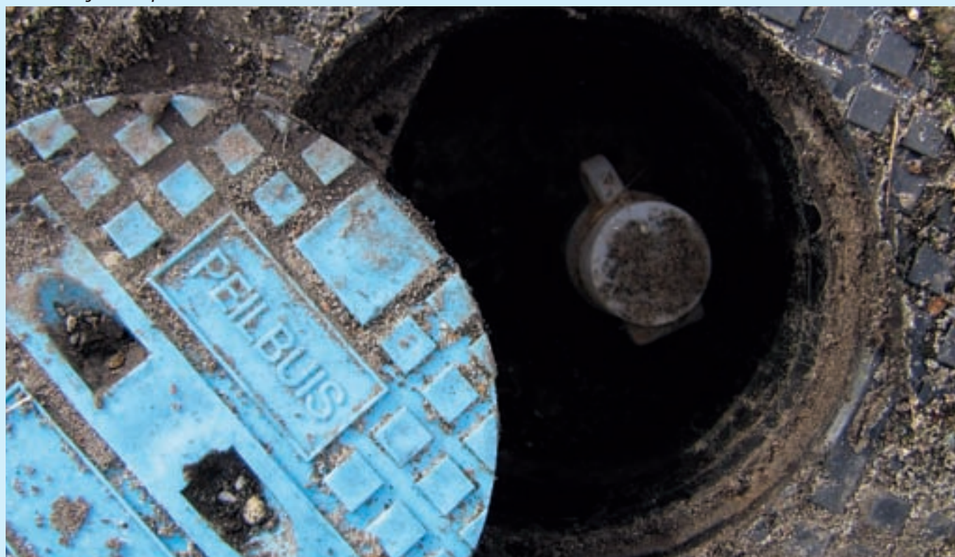
Eén van de 59 grondwaterpeilbuizen in Barendrecht.
