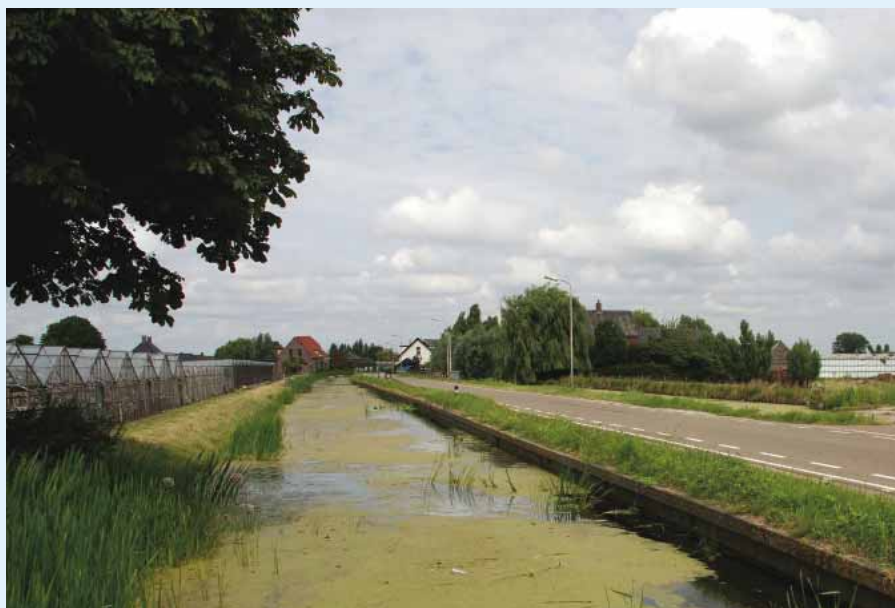
Eén van de clustergebieden, de Oude Leede, waarin goed is af te leiden dat graafwerkzaamheden voor de riolering complex zouden worden.
